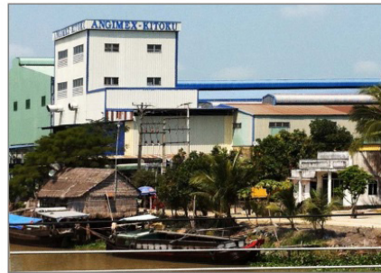
乾燥・粳摺り新設工場
