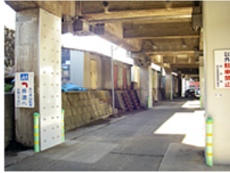
【施工対象例：鉄道の橋脚、一般・高速道路の橋脚など】
