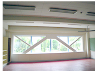
【施工対象例：学校、病院、官公庁舎、公民館など】
