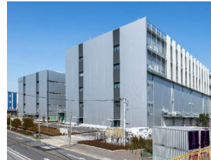
澁澤 ABC ビルディング 2 号館 (道路側)
