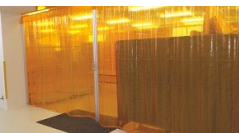
工場間仕切り
