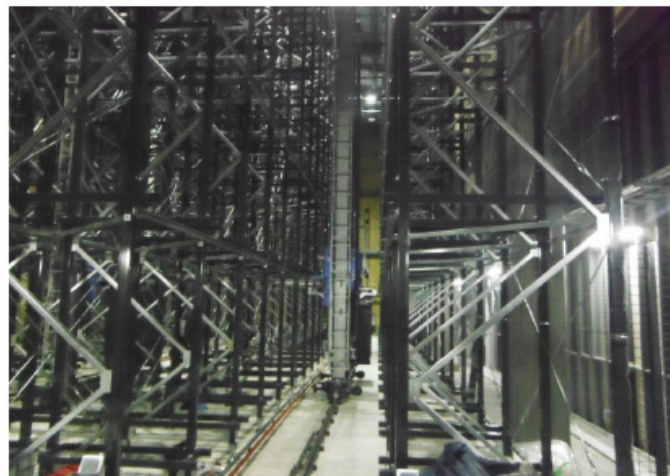
増築2階部分 自動倉庫
