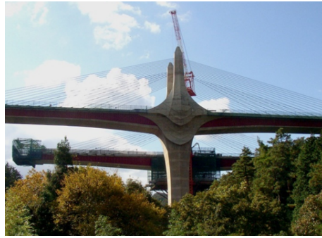
斜張橋主塔部
