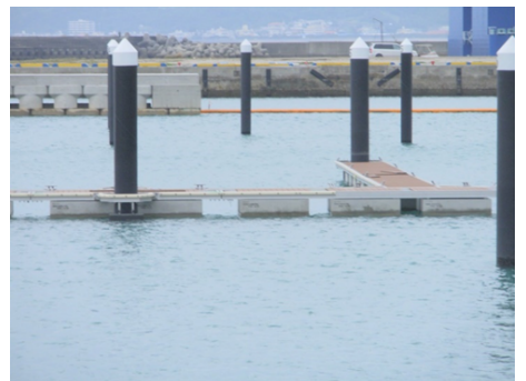
浮桟橋の土台用発泡スチロール
