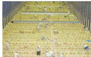
エンジニアリング事業 築炉中のコークス炉
