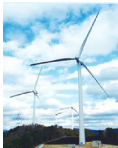
陸上風力発電設備
