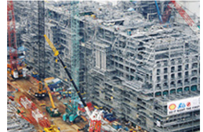
シンガポールでの石油化学分解炉建設工事 出所：会社ホームページより転載
