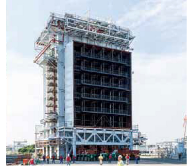
火力発電所の高温モジュールの構内輸送
