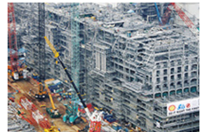
シンガポールでの石油化学分解炉建設工事
