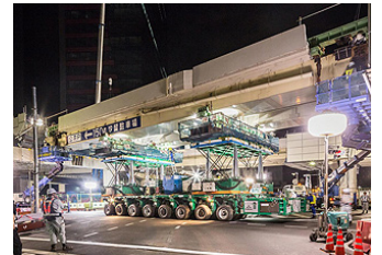
特殊車輛を使用した橋梁架替工事
