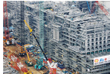
シンガポールでの石油化学分解炉建設工事 出所：会社ホームページより転載
