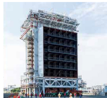
火力発電所の高温モジュールの構内輸送
