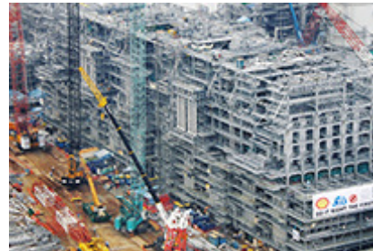
シンガポールでの石油化学分解炉建設工事
