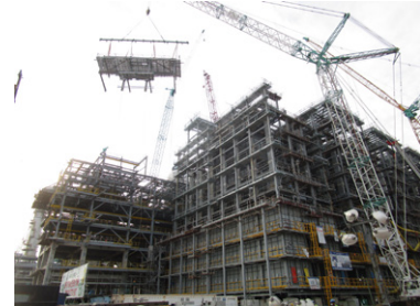
マレーシアのエチレン製造設備建設工事
