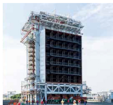
火力発電所の高温モジュールの構内輸送
