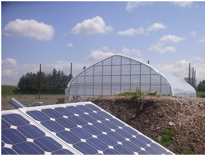
太陽光パネル設備
