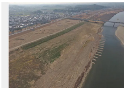
兵庫県 加古川下流部堆砂撤去工事
