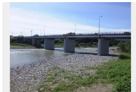
兵庫県 中寺北条線 中津橋補修・耐震補強工事
