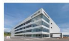
三島工場 (2025年12月体制構築完了 (筆許可、バリエーション等)、2026年2月本格稼働予定)
