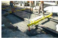
路面電車軌道 (ハンガリー)
