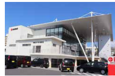
ハイブリッドプレストレスト コンクリート屋根 (日本 沖縄県)
