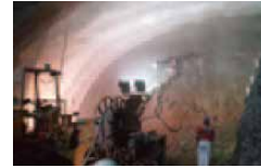
トンネル内壁への吹付
