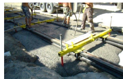
路面電車軌道 (ハンガリー)
