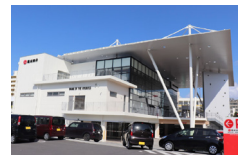
ハイブリッドプレストレスト コンクリート屋根 (日本 沖縄県)
