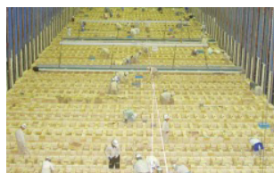
築炉中のコークス炉
