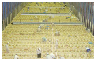
築炉中のコークス炉
